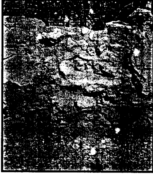
صورة (9): التفكك الحبيبي في جدران السور الخارجي بمسجد الجعلانية. ناظراً نحو الجنوب الشرقي.
